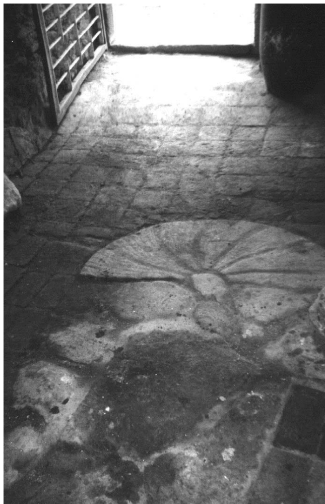
Foto 4. Recuperació del nivell original del terra del molí.
