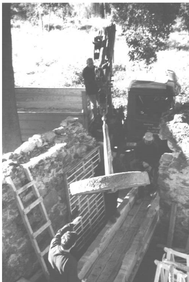
Foto 3. Descarregament de la mola sobirana del molí per ubicar-la al seu emplaçament original (25 de gener de 2003).
