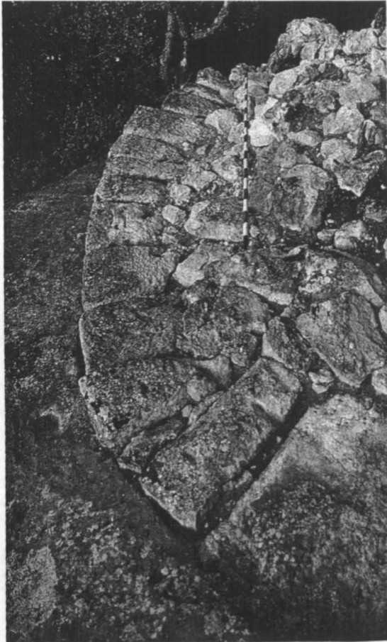
Ilustración 1: Vista general de la muralla, en la que puede apreciarse la técnica constructiva empleada en su construcción.
